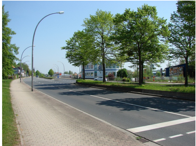
Barriere Braunschweiger Straße (B248)
