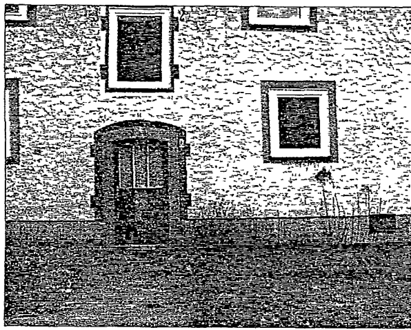
In manchen Häusern in der Ostsiedlung wohnt niemand mehr – die Türen sind verbarrikiert Fotos (5) Kerstin Loehr
