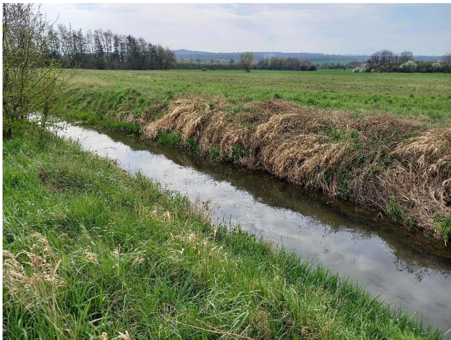
Abb. 2.3: ausgebautes Trapezprofil der Fuhse im Plangebiet (AGWA 17.4.2023)
